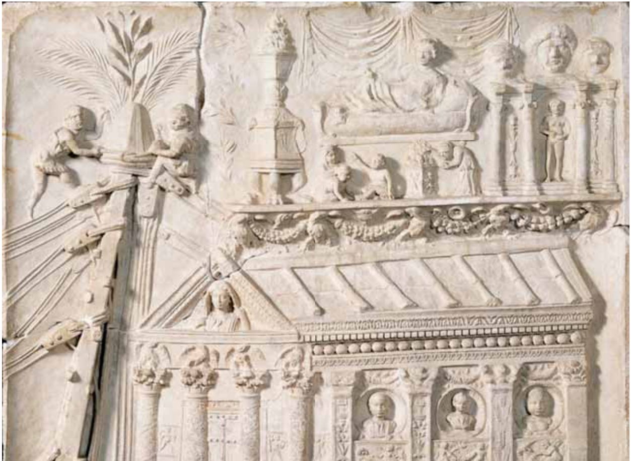
Figura 3: Decorazione della tomba di Haterii che rappresenta un edificio funebre con rappresentato a sinistra un elevatore
