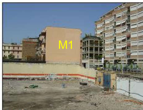
VISTA A EDIFICIO IN MURATURA (struttura in muratura con fondazioni superficiali del tipo a sacco)
