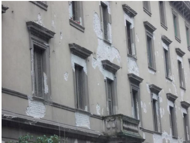
Intonaci ammalorati
