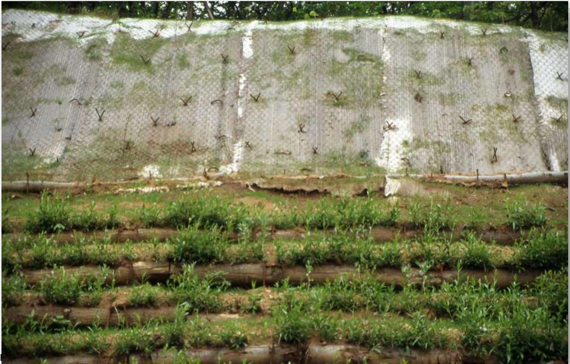
**Figura - Rivestimento vegetativo in rete e biofeltro** (da F. Boccalaro, 2007)
