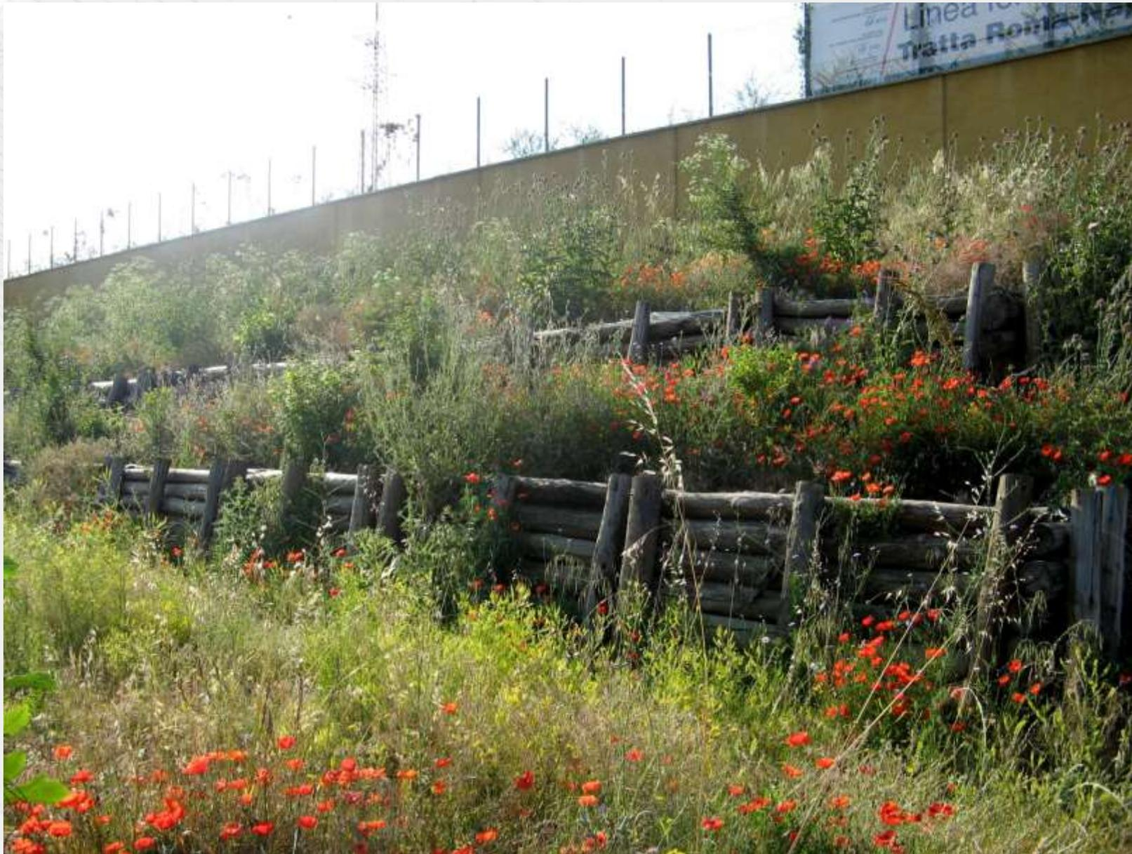
**Figura** - *Mitigazione Ambientale EM01 (palificate) a Lunghezza (da F. Boccalaro, 2008)*
