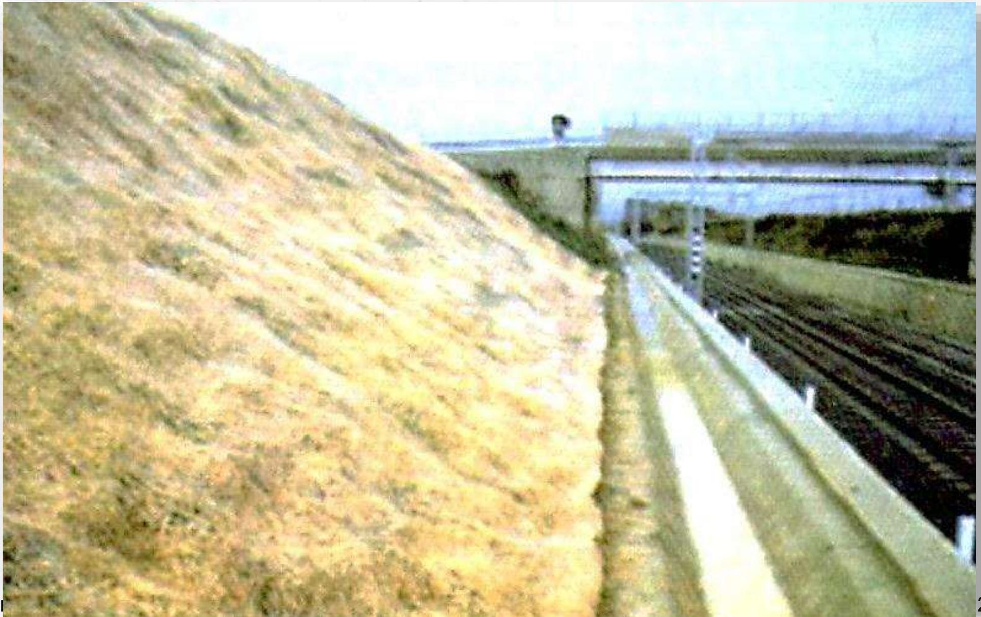
**Figura** - *Scarpata con copertura a lupinella al km 201 della linea ferroviaria DD Roma-Firenze (da Cornelini, 1990)*
