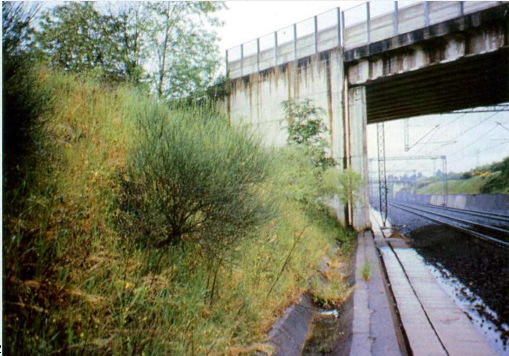
**Figura** - Scarpata con chiodatura del terreno prima dell'idrosemina lungo la linea ferroviaria DD Roma-Firenze (da RFI, 2001)
