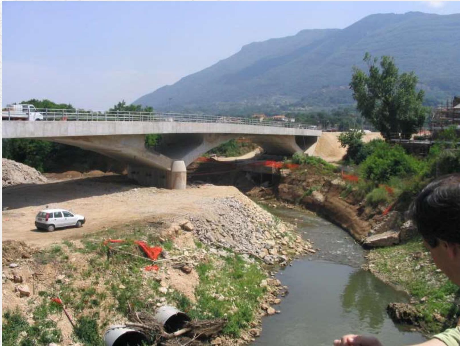
**Figura** - Sistemazione di sponde del fiume Sacco al cavalcavia IV01 di Sgurgola con gabbioni e biostuoie (da F. Boccalaro, 2006)
