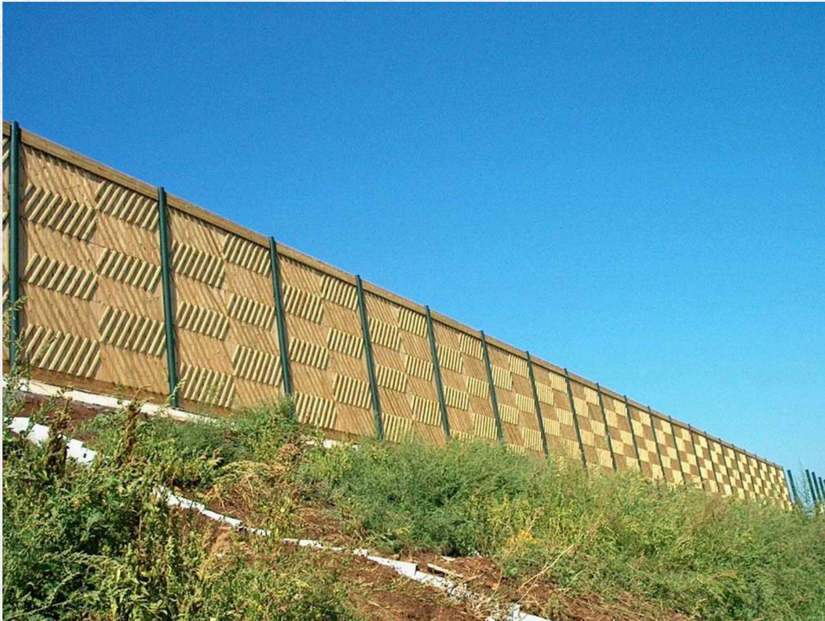
**Figura - Barriere in metallo e pmma o polimetilmetacrilato (da F. Boccalaro, 2006)**
