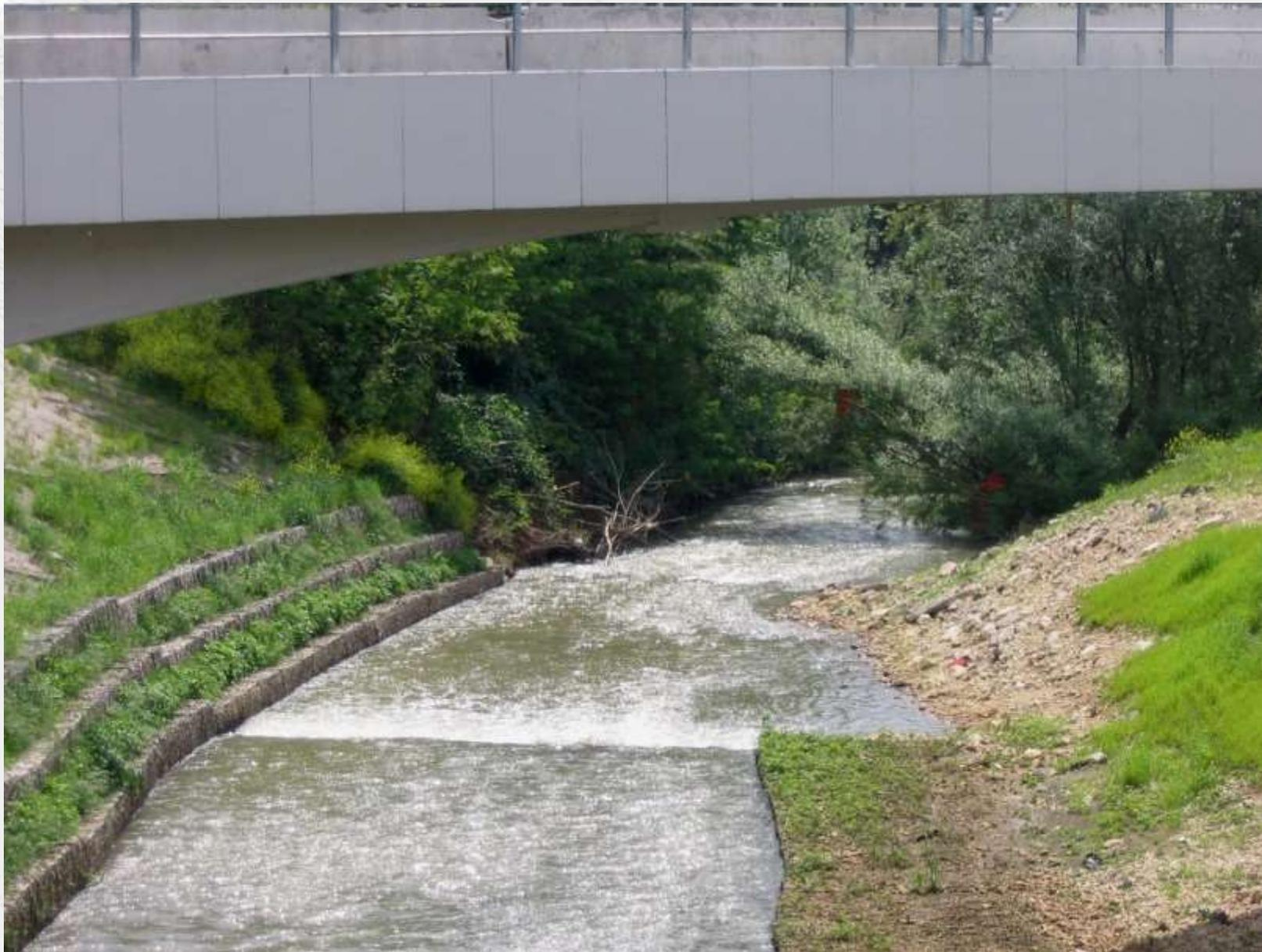
**Figura** - Sistemazione di sponde del fiume Sacco al cavalcavia IV01 di Sgurgola con gabbioni e biostuoie (da F. Boccalaro, 2008)
