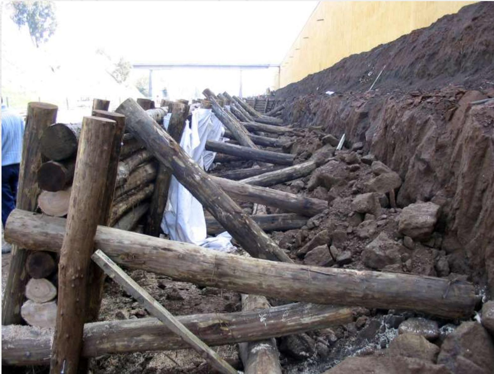
**Figura** - *Mitigazione Ambientale EM01 (palificate) a Lunghezza (da F. Boccalaro, 2007)*
