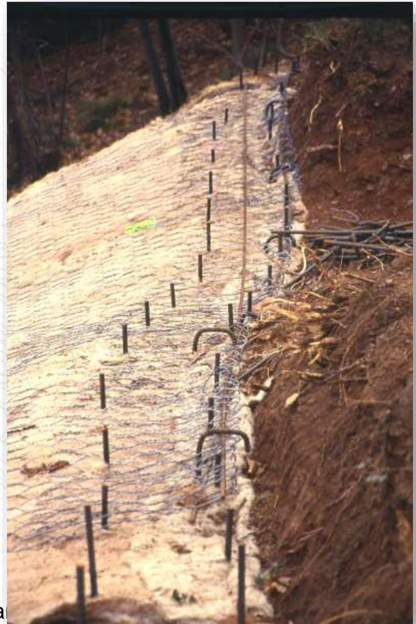
**Figura - Rivestimento vegetativo in rete e biofeltro (da F. Boccalaro, 1994)**
