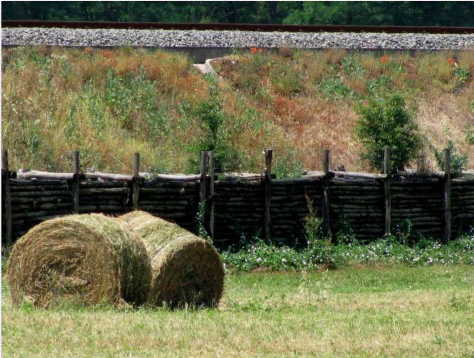
**Figura** - *Mitigazione Ambientale EM01 (palificate) a Lunghezza (da F. Boccalaro, 2005)*
