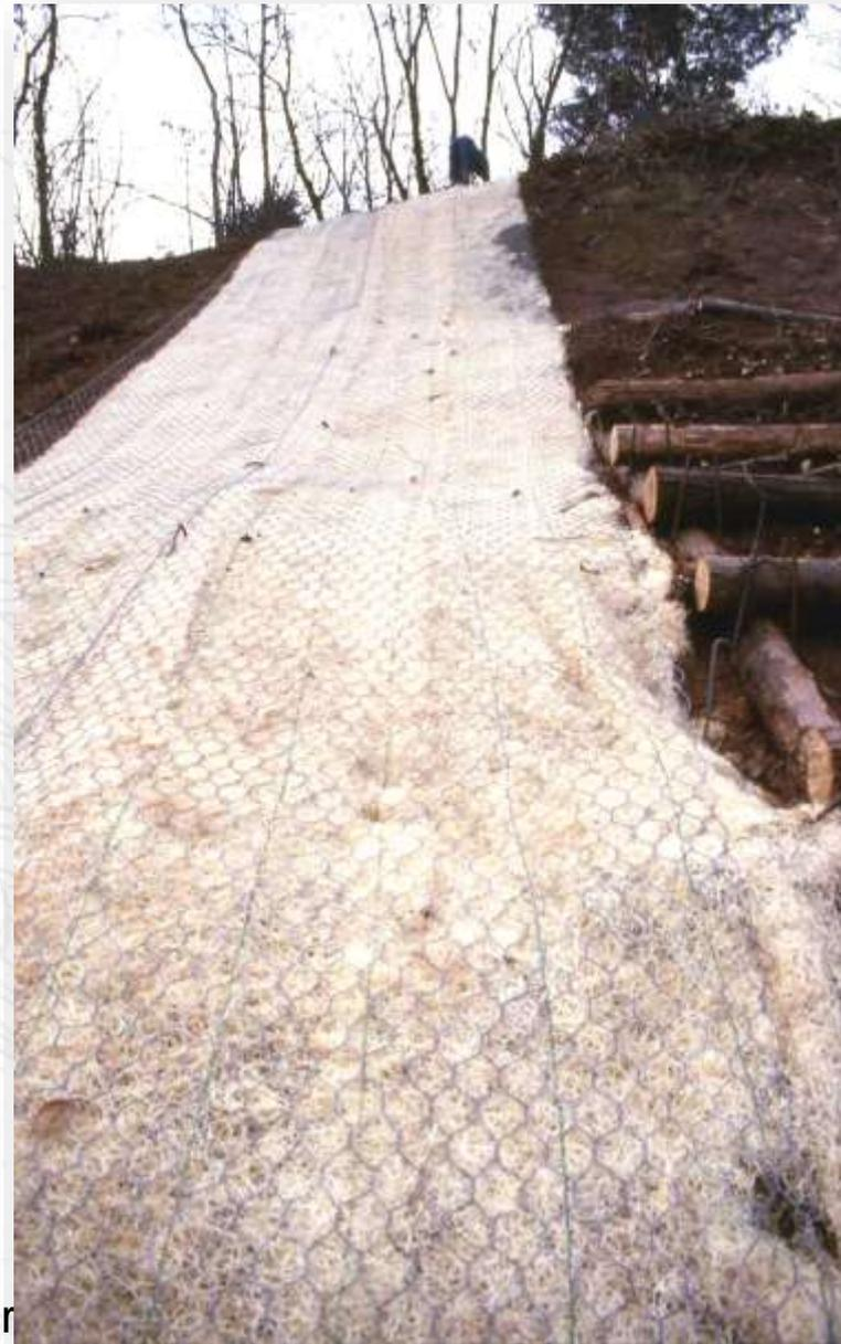
**Figura** - *Rivestimento vegetativo in rete e biofeltro* (da F. Boccalaro, 1995)
