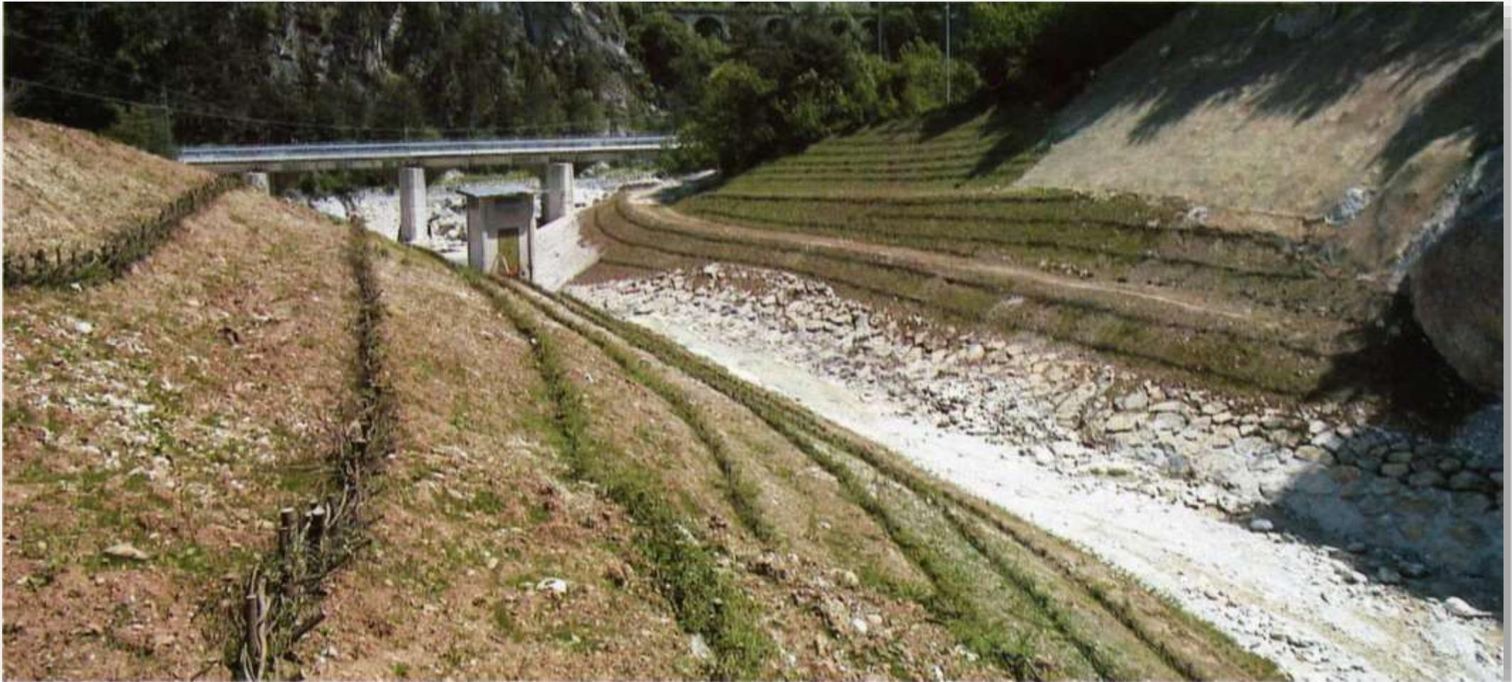
**Figura - Sistemazione di spalla ponte ad arco a Tarvisio (da Boccalaro, 2001)**
