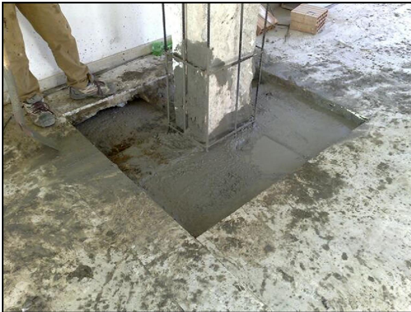
Getto del calcestruzzo in fondazione
