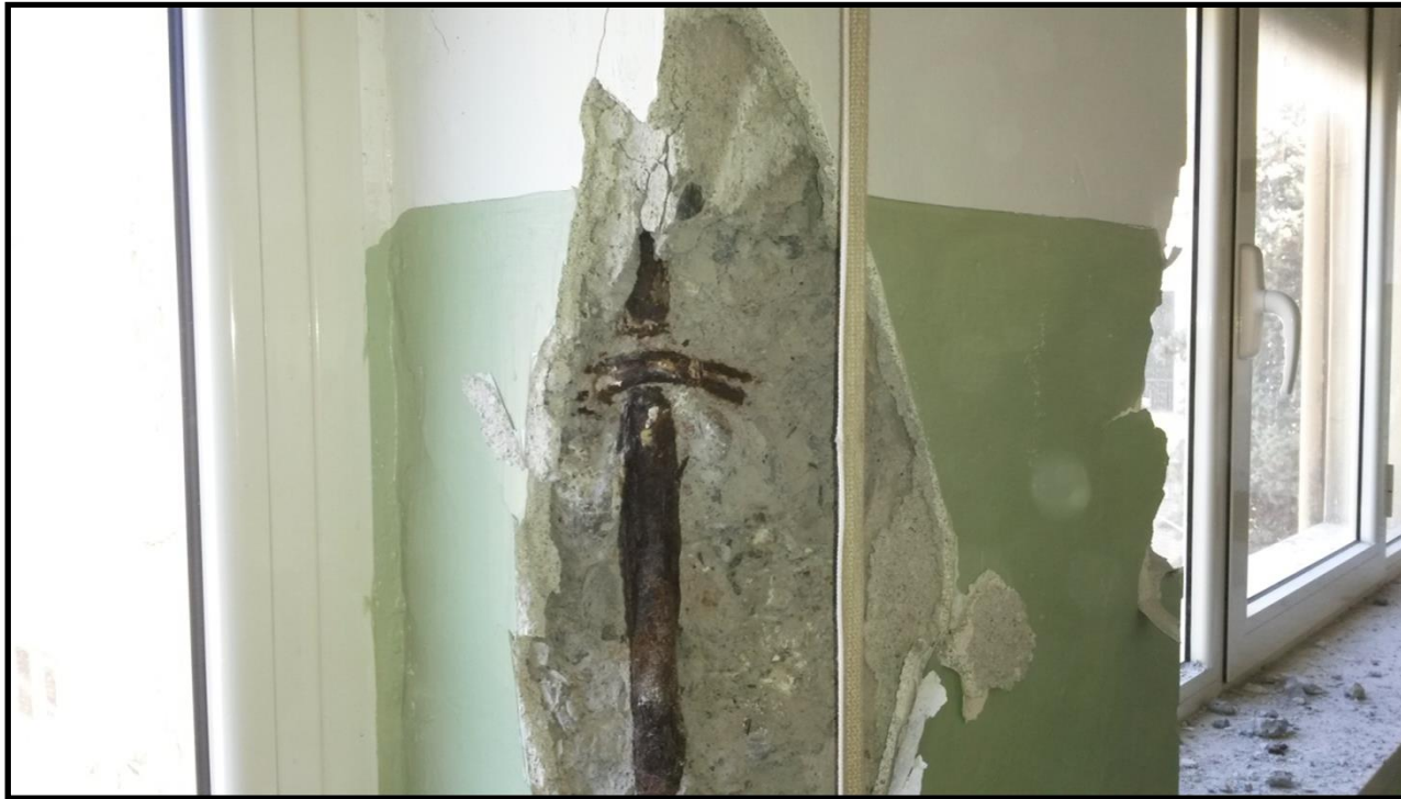
Staffe chiuse a 90^\circ senza capacità di confinare il nucleo di cls
