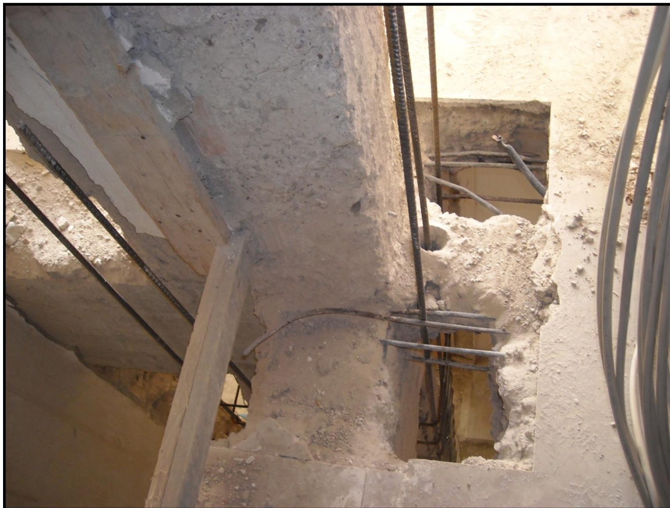
Posizionamento delle barre di nuovo apporto in elevazione
