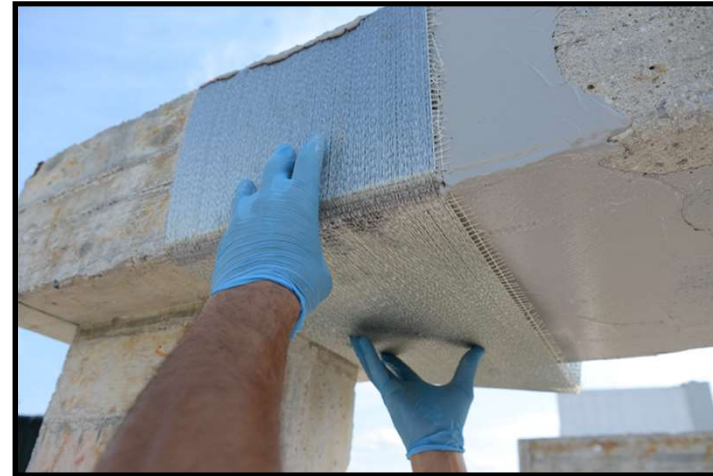
Matrice inorganica con tessuti in fibra di acciaio
