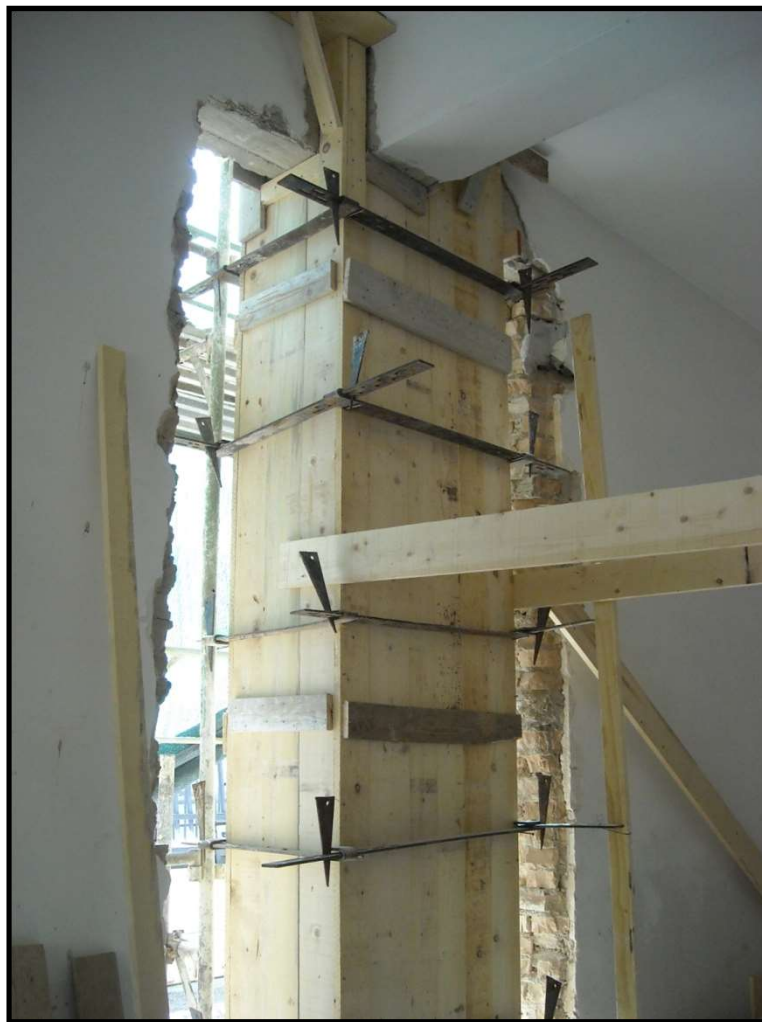
Casseratura della gabbia di armatura
