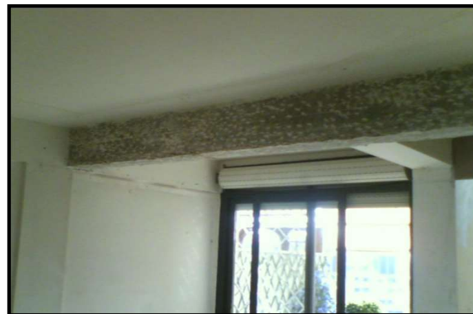
Trave in c.a. non rinforzata
