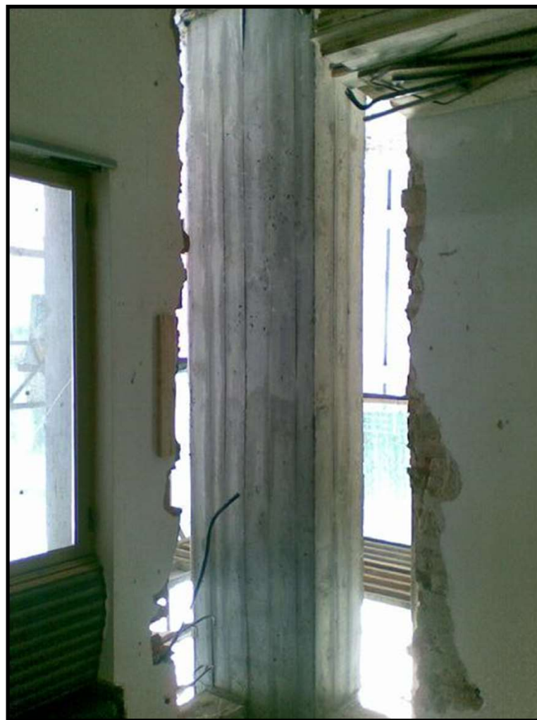
Disarmo del pilastro dopo la stagionatura del getto di betoncino
