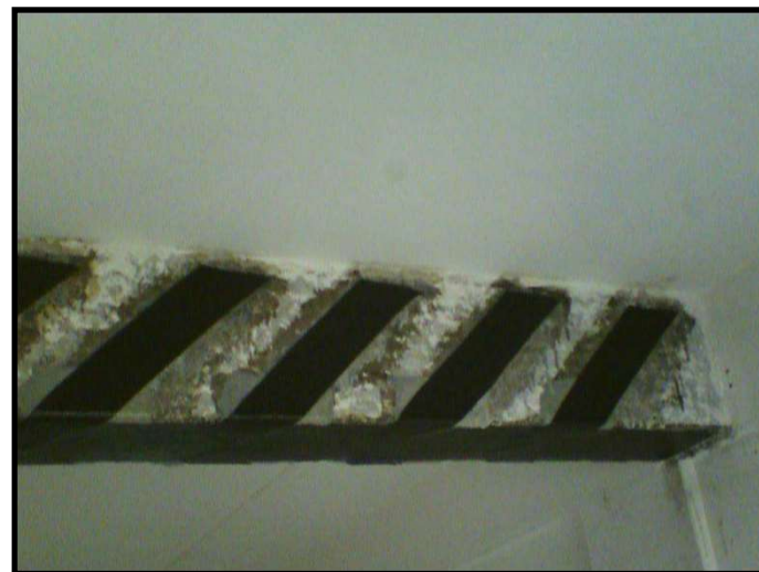
Trave rinforzata a taglio (fibre di carbonio verticali a 45°) ed a flessione (fibre carbonio all'intradosso)
