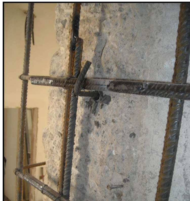
Spinotto metallico fissato con resina epossidica
