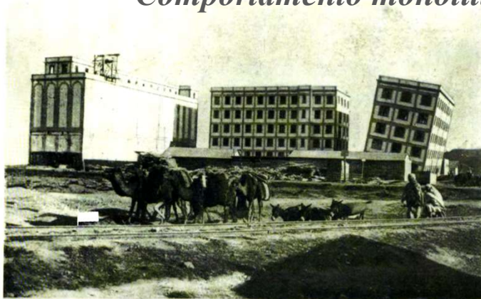
Vue d'ensemble prise du côté B du plan (fig. 2). Le bâtiment n. 1, à gauche, est celui qui a été édifié précédemment. Sur la terrasse on voit les constructions qui ont été ajoutées après le redressement opéré. Le voisinage du bâtiment n. 2, qui n'a éprouvé qu'un mouvement insignifiant, permet d'évaluer l'enfoncement subi par le bâtiment n. 1.
