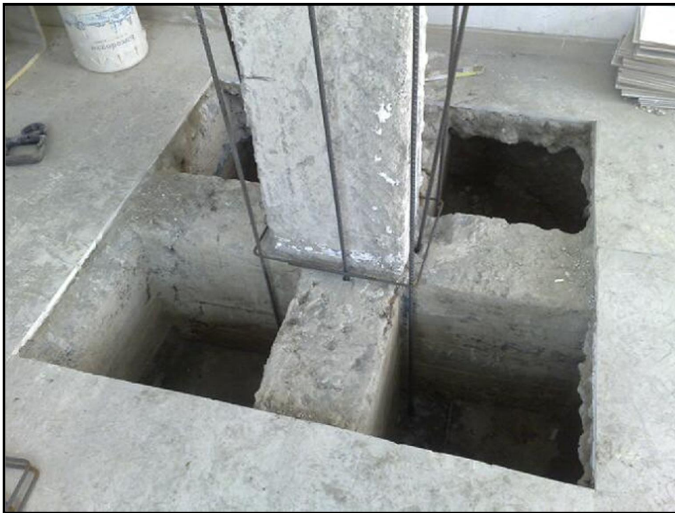
Posizionamento delle barre di nuovo apporto in fondazione
