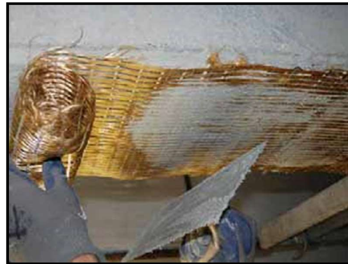
Matrice inorganica con reti in fibra di PBO
