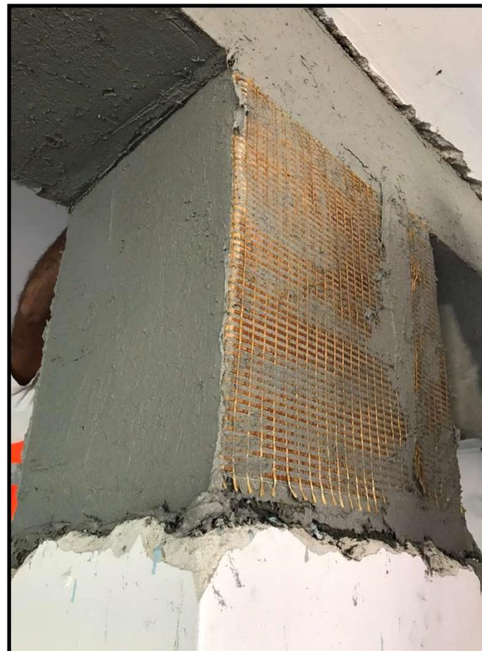
*Rinforzo con FRCM (fibre di pbo)*
