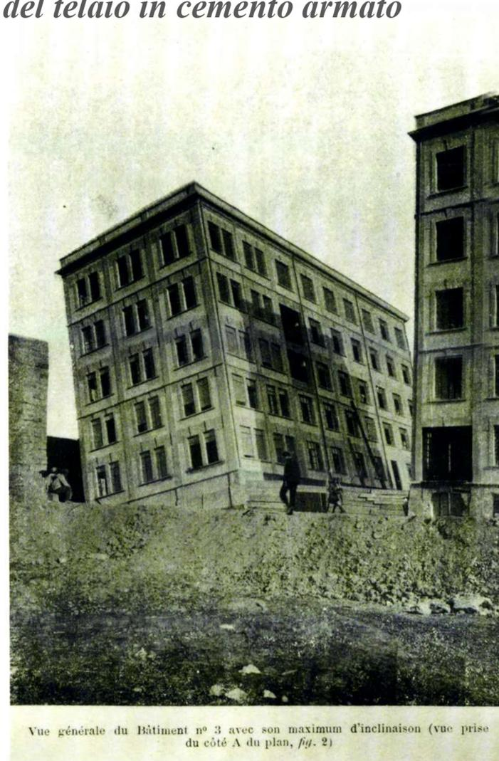
Vue générale du Bâtiment n. 3 avec son maximum d'inclinaison (vue prise du côté A du plan, fig. 2)
