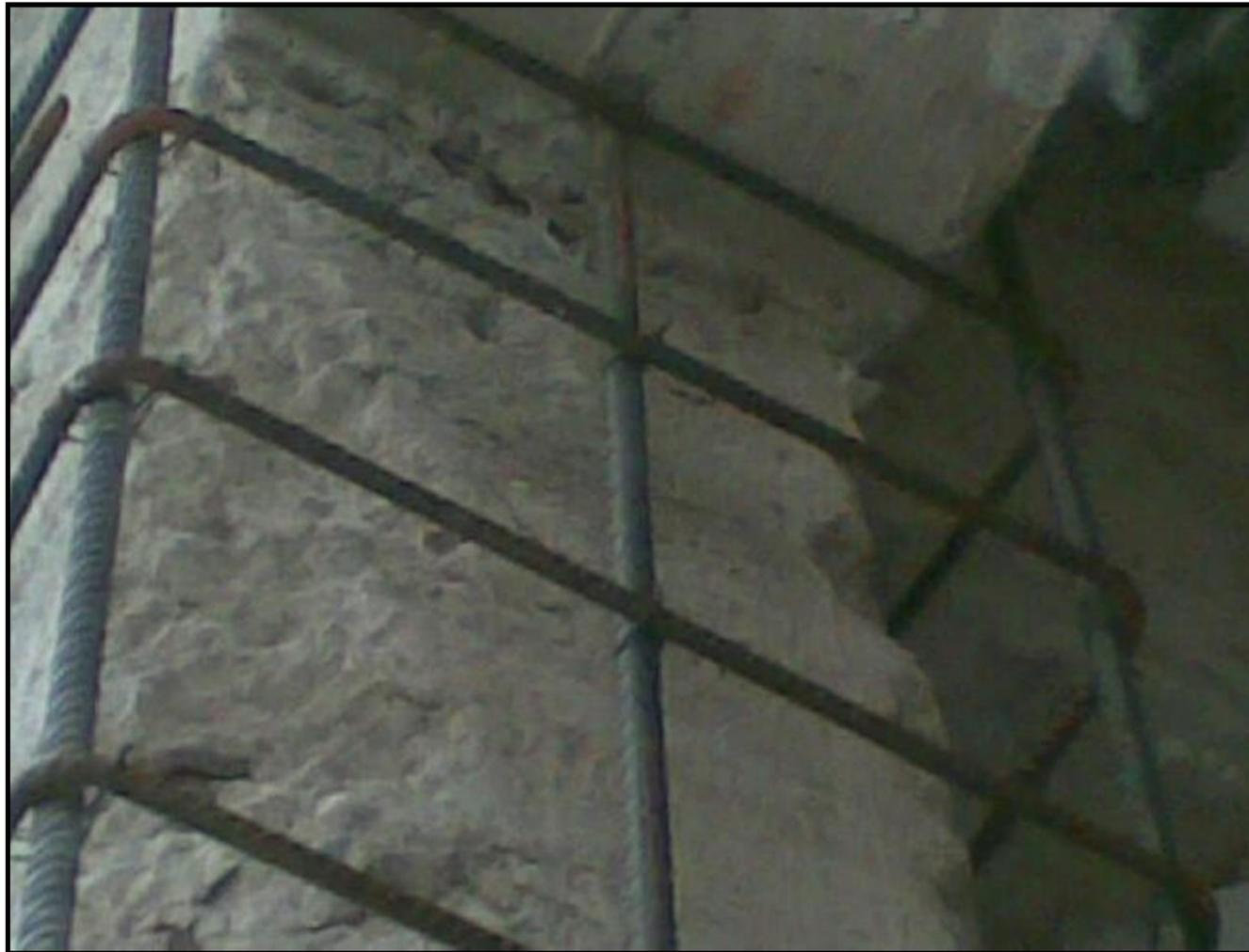
*Ancoraggio nelle travi esistenti delle barre interne alla faccia del pilastro*
