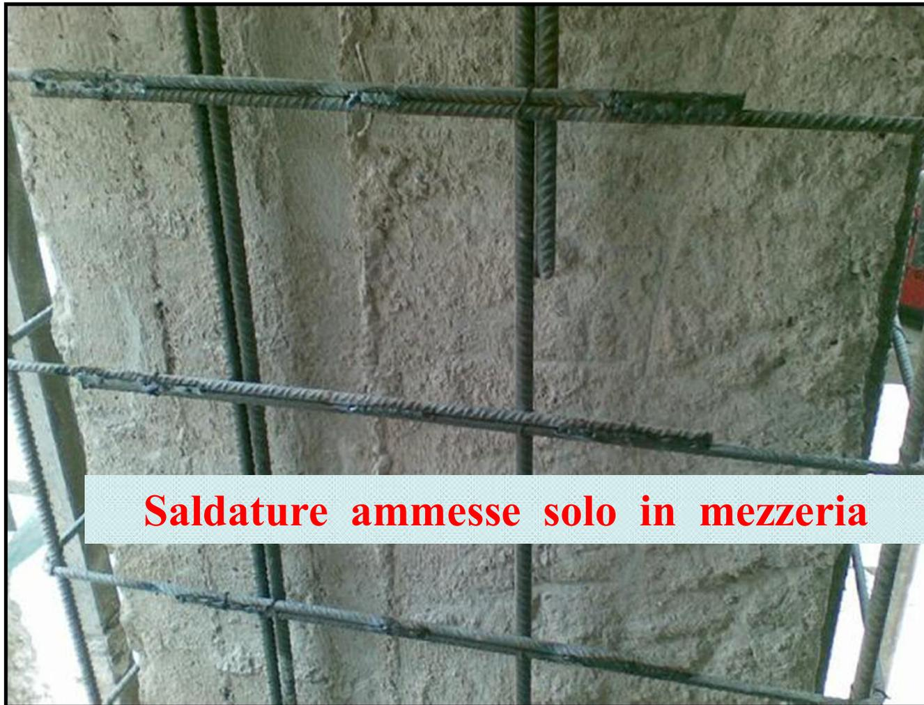
**Saldature ammesse solo in mezzeria**
