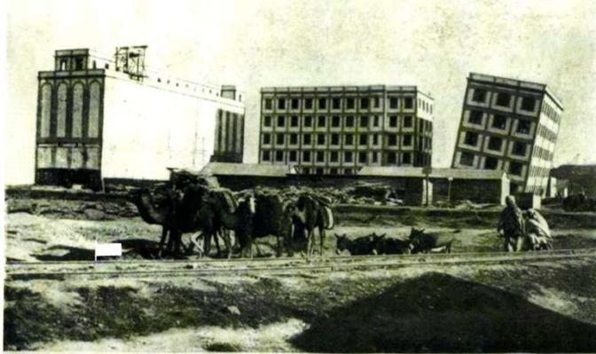
Vue d'ensemble prise du côté B du plan (fig. 2). Le bâtiment n. 1, à gauche, est celui qui a été édifié précédemment. Sur la terrasse on voit les constructions qui ont été ajoutées après le tassement opéré. Le voisinage du bâtiment n. 2, qui n'a éprouvé qu'un mouvement insignifiant, permet d'évaluer l'enfoncement subi par le bâtiment n. 1.
