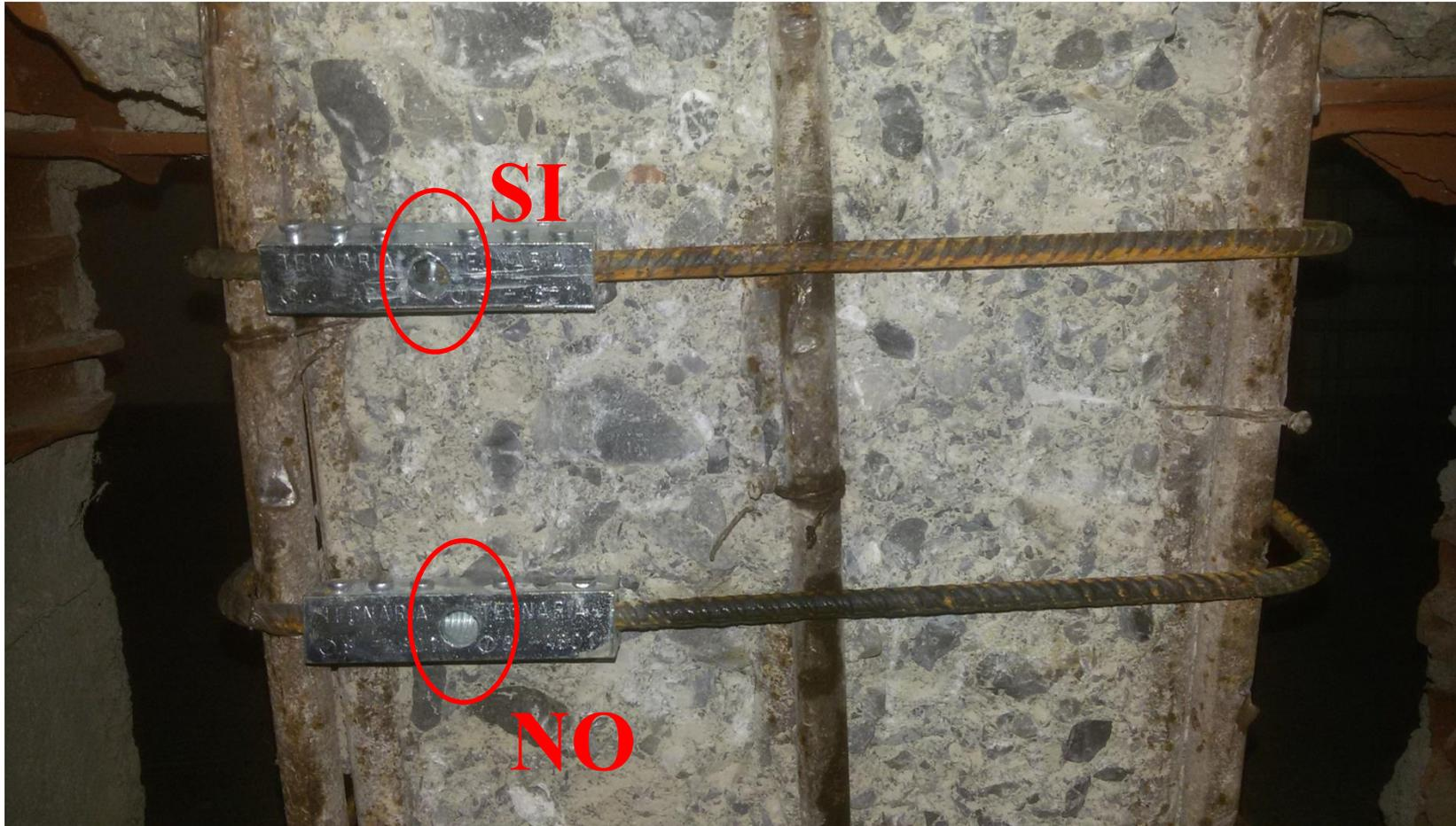
*Importanza del foro di ispezione nel controllo della messa in opera*
