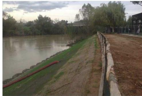
*Foto 16 e Foto 17 – Completamento in terra vegetale dello strato sommitale (0,8 m) della sponda golenale e posizionamento della staccionata lignea di delimitazione dal piano golenale*
