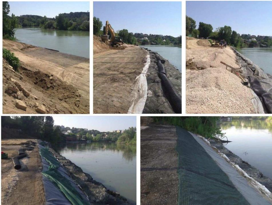
Foto 11, 12, 13, 14, 15 – Fasi di ripristino della sponda in terra armata
