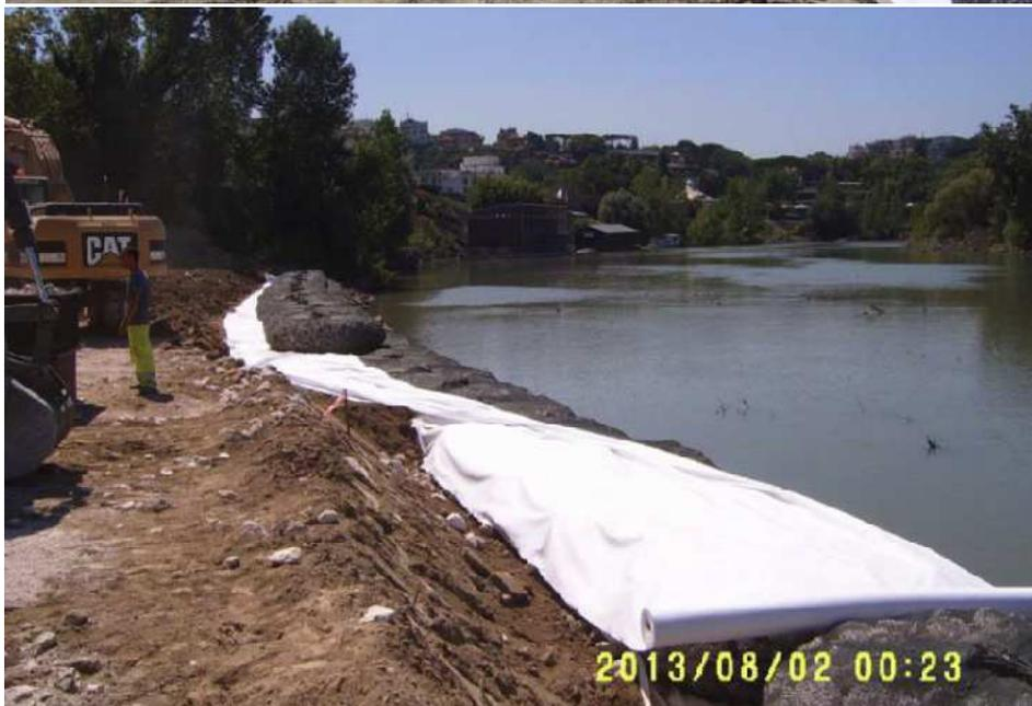
*Foto 7 e Foto 8 – Disposizione al piede della sponda degli elementi drenanti costituiti da sacconi in rete sintetica riempiti di pietrame (tipo Filter Unit 4T)*
