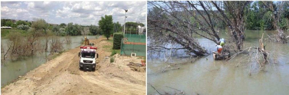
*Foto 3 e Foto 4 – Prime attività di cantiere. Messa in sicurezza dei fronti di frana, pista di accesso al piede della sponda ed eliminazione della vegetazione d'alto fusto collassata in alveo*
