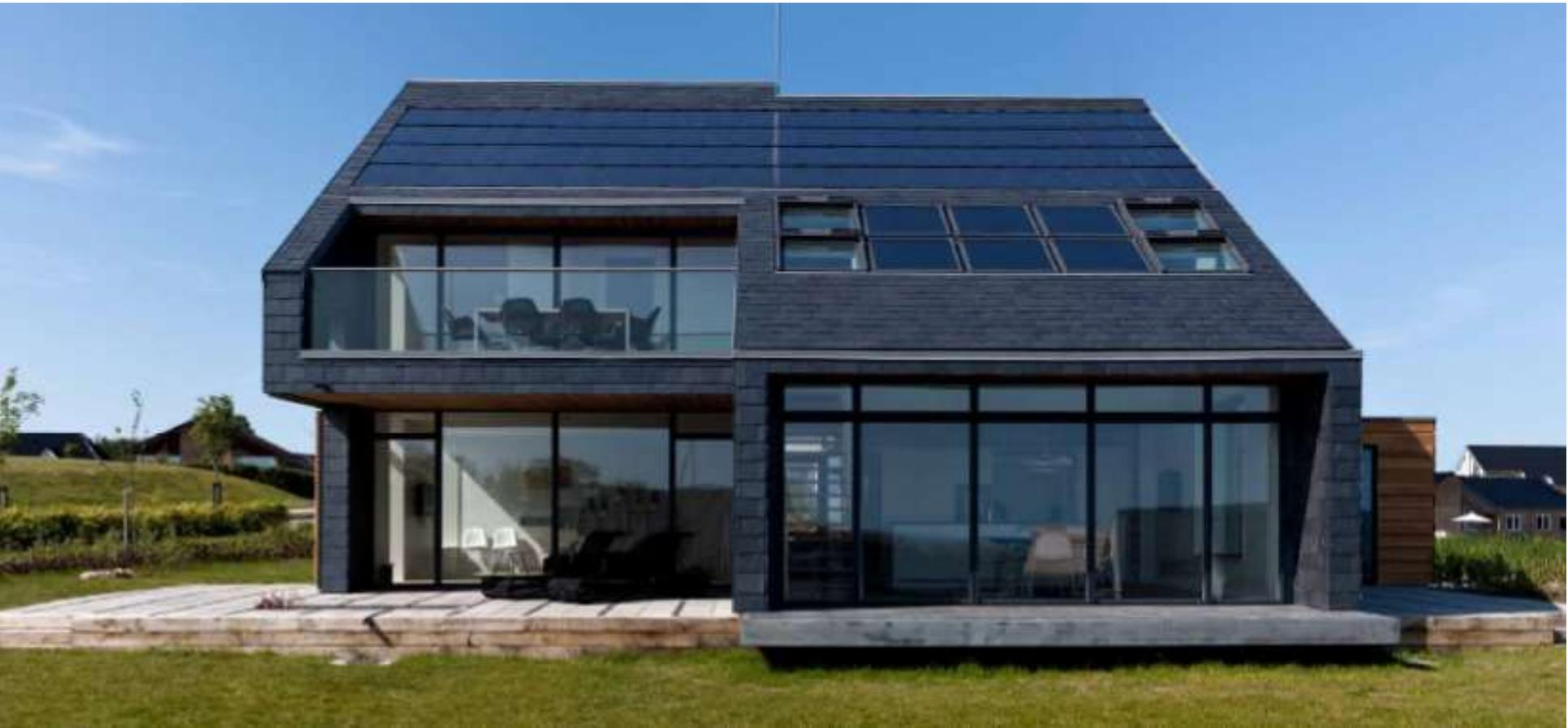
La scelta del rivestimento in ardesia della facciata e del tetto riflette l'auspicio per una lunga durata, bassa influenza di emissioni CO2 e manutenzione minima, ma anche il desiderio di integrare le superfici scure delle celle solari, i pannelli solari e le finestre in una bella composizione globale.
