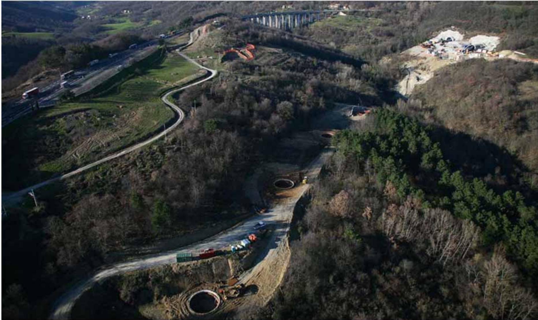
Sasso Marconi - Barberino; marzo_2007; Lotto 12; Viadotto Fiumicello Nord
