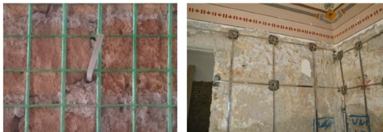
Betoncino armato in FRP composito
