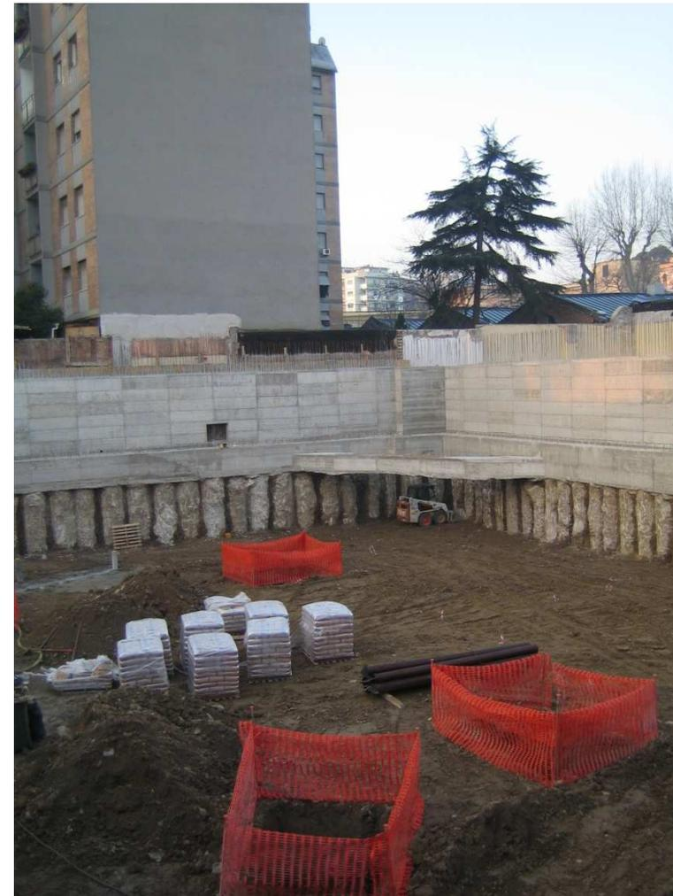
PARTICOLARE AREA DI CANTIERE DURANTE IL 1° SCAVO: PUNTONAMENTI D'ANGOLO (IN C.A.)
